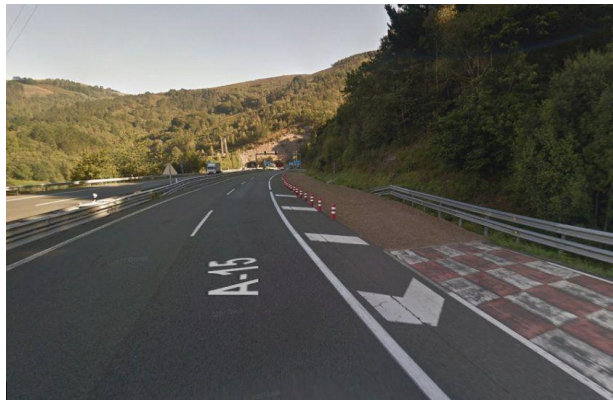
Figura 3: Lecho de frenado. Fuente: Aula Carreteras.
