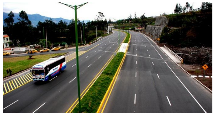
Figura 6: Derecho de Vía en Ecuador.
